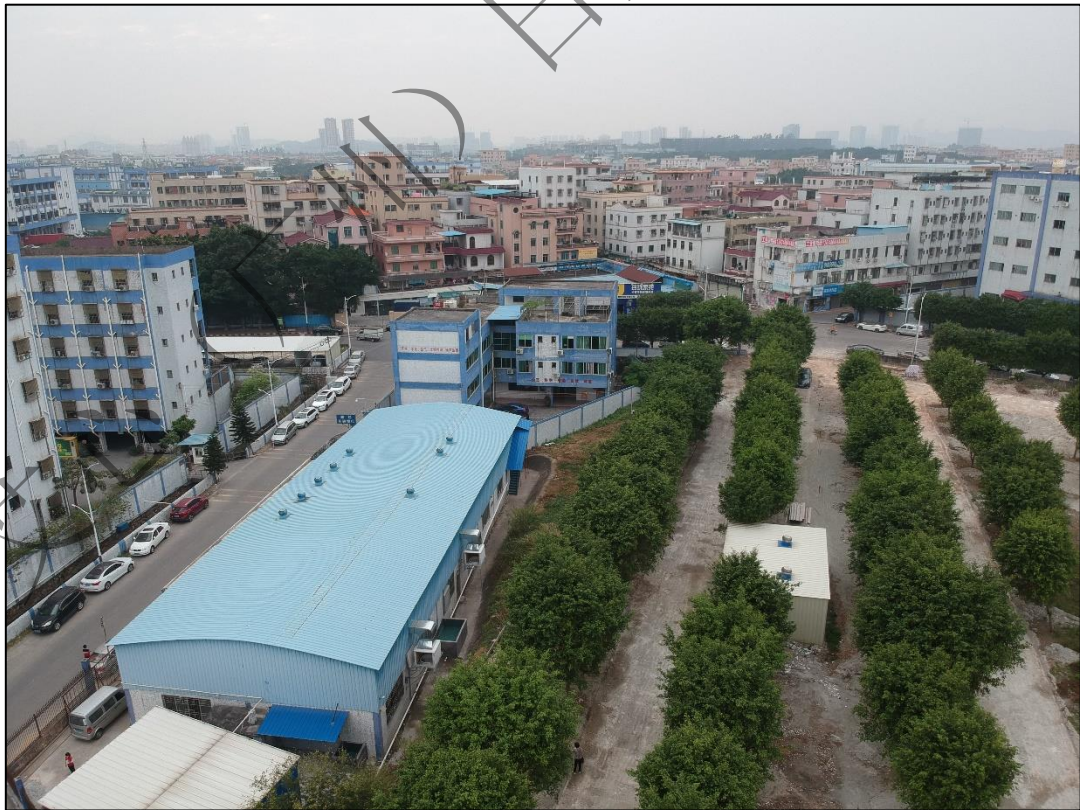
项目厂区外观及北侧通道。
